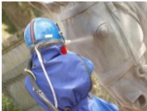
Opération de sablage. ©Y.BHOURIS/CG77 - D.R.
